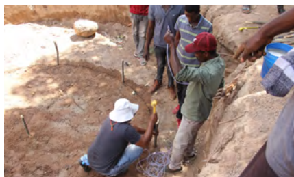
Figura 10 - Demarcação do Fundo da Cisterna para Construção do Piso
