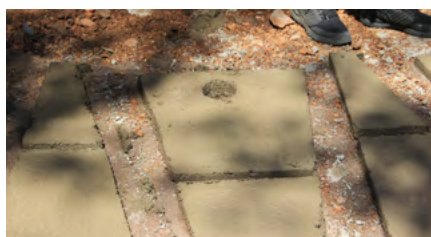
Figura 9 – Detalhe da Placa com um Furo para de Captação da Água
