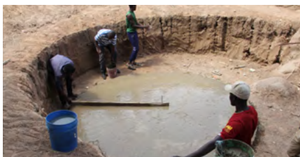
Figura 11 - Demarcação do nível e construção do piso
