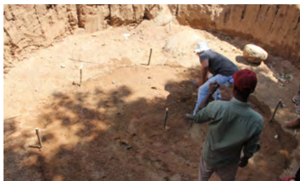
Figura 10 - Demarcação do Fundo da Cisterna para Construção do Piso
