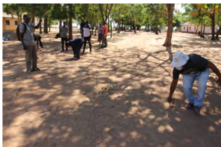
Figura 1 - Marcação do Local da Cisterna
