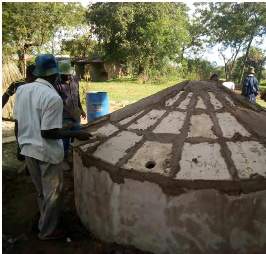
Figura 17 - Detalhes da Montagem da Tampa da Cisterna
