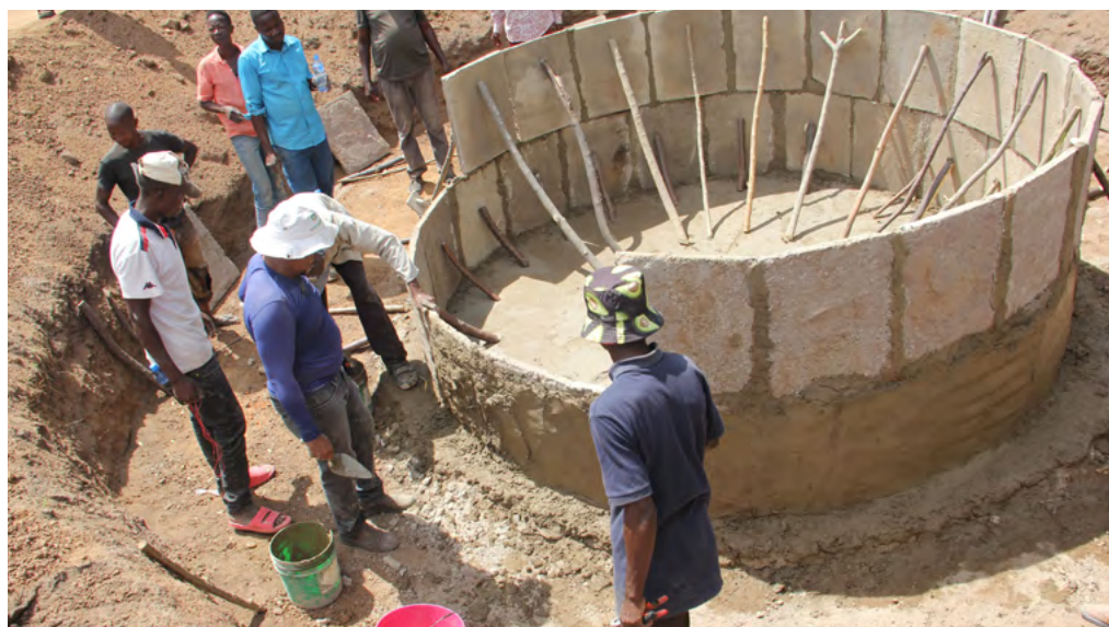
Figura 15 – Detalhes da Montagem da 2ª. Fileira
