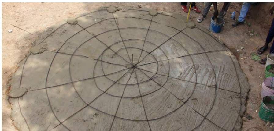
Figura 12 - Estrutura da Malha de Ferro ¼' no Fundo da Cisterna
