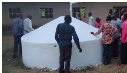
Figura 18 – Aspectos do Reboco Externo da Cisterna
