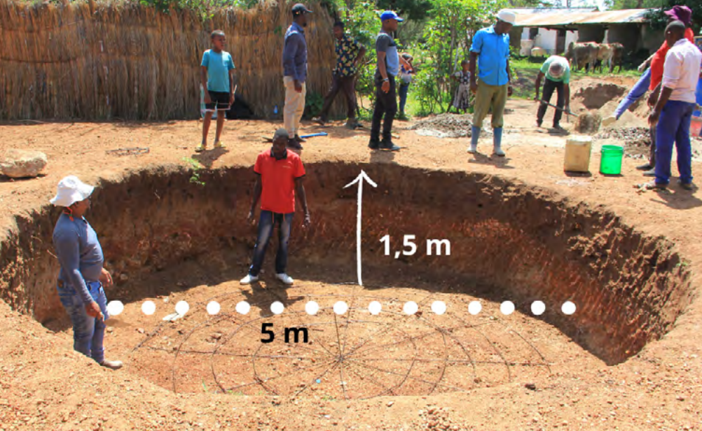
Figura 2 - Dimensões da Escavação
