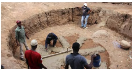
Figura 11 - Demarcação do nível e construção do piso
