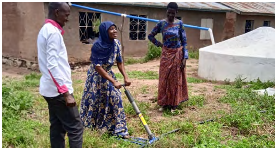
Figura 19 - Cisterna de Placas com Sistema de Captação e Retirada D'água
