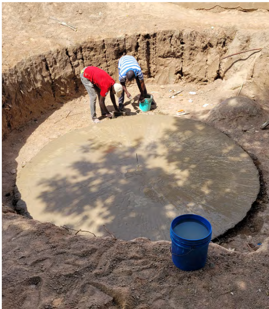
Figura 13 – Aspecto do Piso do Fundo da Cisterna
