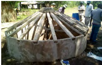
Figura 16 – Detalhes da Estrutura da Tampa da Cisterna
