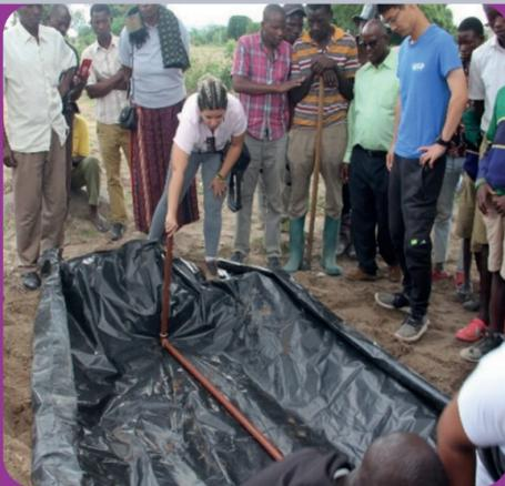
Com um cano PVC de 1 polegada medindo 6 metros, corte meio metro de cada lado. Fure o cano de forma alternada com espaço de 30 centímetros de um furo para o outro. Com dois joelhos de 1 polegada, encaixe as sobras do cano de um lado e do outro.
