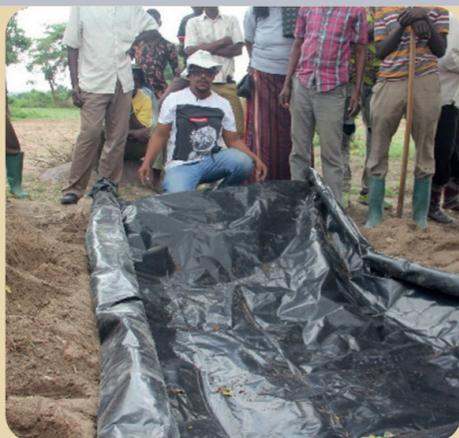
Com uma lona de 100 a 200 micras, forra-se o canteiro tendo cuidado com o nivelamento para que não fiquem buracos ou poças de lama. Se for pisar na lona, cuidado para não rasgar! Você pode dobrar as laterais da lona, cortar as sobras com cuidado, ou colocar pedras nas laterais, para dar um melhor acabamento ao canteiro.
