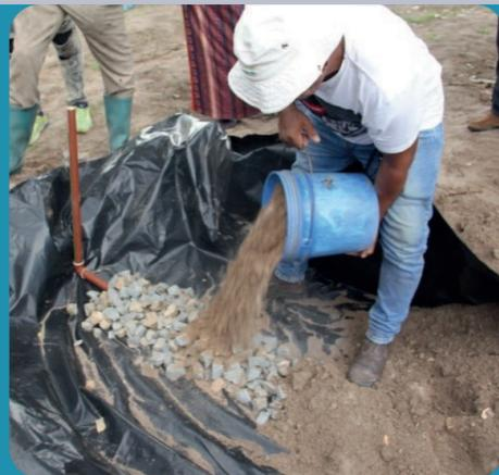
Cubra o cano com telhas, pedras ou garrafas pets cortadas ao meio para evitar a entrada de terra nos orifícios. É recomendável, antes de cobrir com terra, despejar um balde de água de um lado e do outro do cano para verificar a distribuição homogênea da água.
