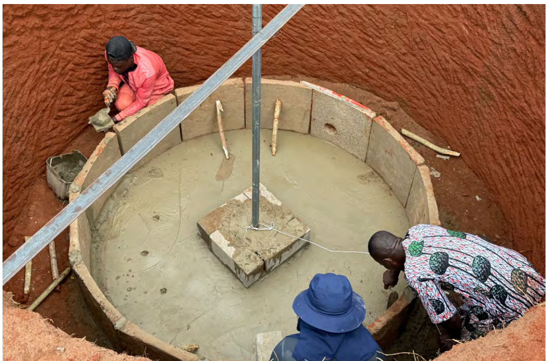
Figure 14 - Base en briques pour le tuyau guide, après achèvement.
