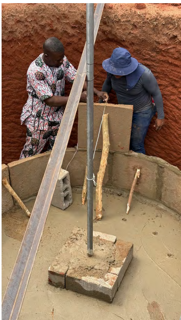
Figure 22 - Alignement du niveau pour la 2 rangée de plaques
