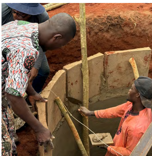
Figure 24 - Détails de l'application de l'enduit entre les plaques de la troisième rangée.
