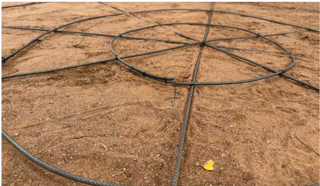
Figure 9 - Armature en fer pour la base.
