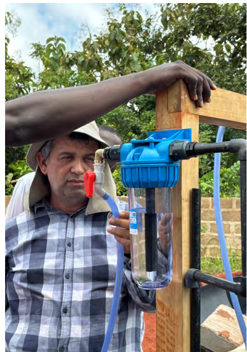
Figure 51 - Filtre coupe-flamme installé
