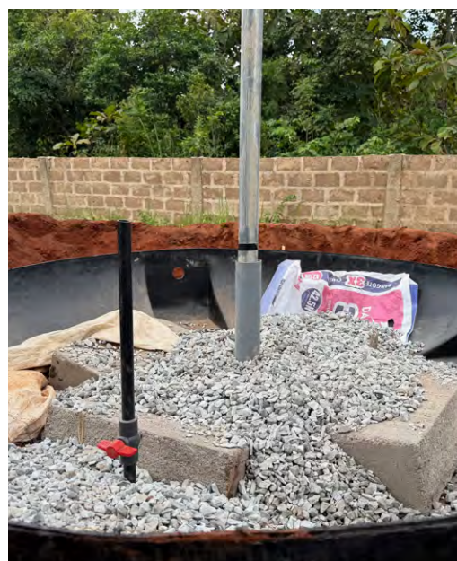
Figure 42 - Finalisation de la mise en place du poids sur la cuve
