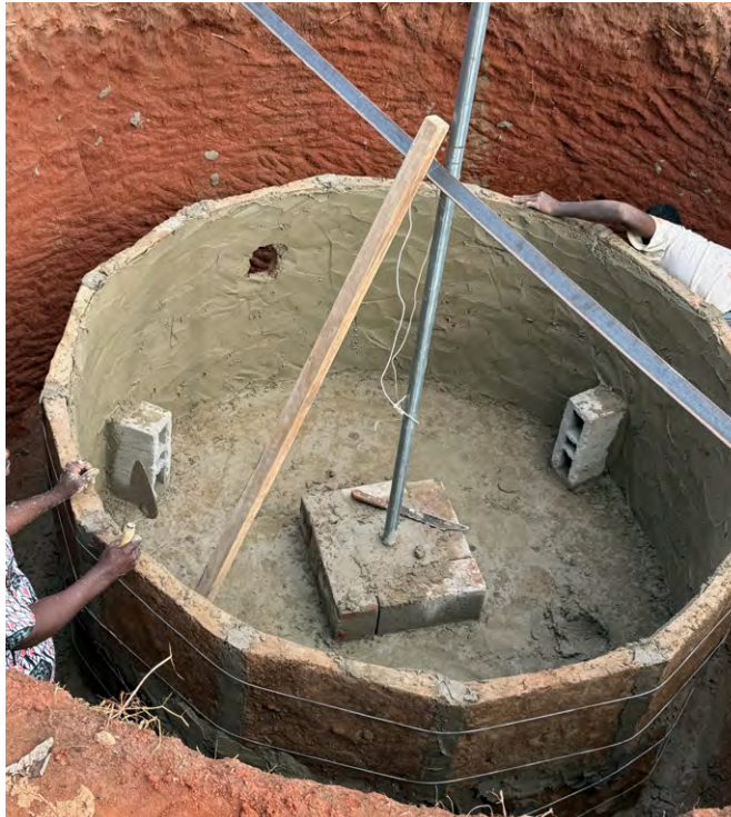
Figure 26 - Ligature du fil de fer sur la cuve.
