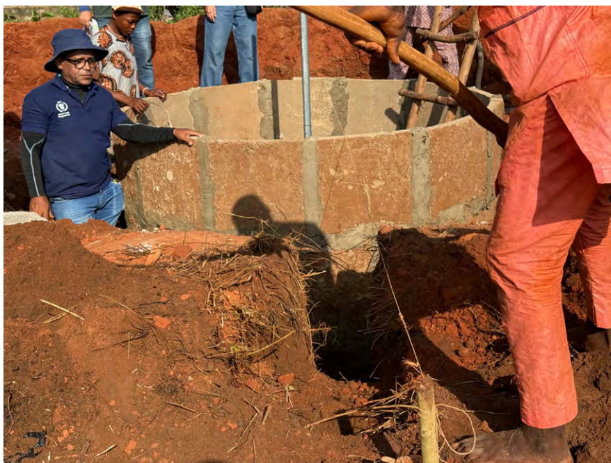
Figure 32 – Illustration de la cuve de chargement.
