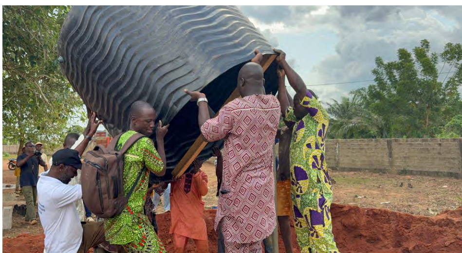
Figure 39 - Mise en place de la cuve de fermentation de manière à centrer le tube guide
