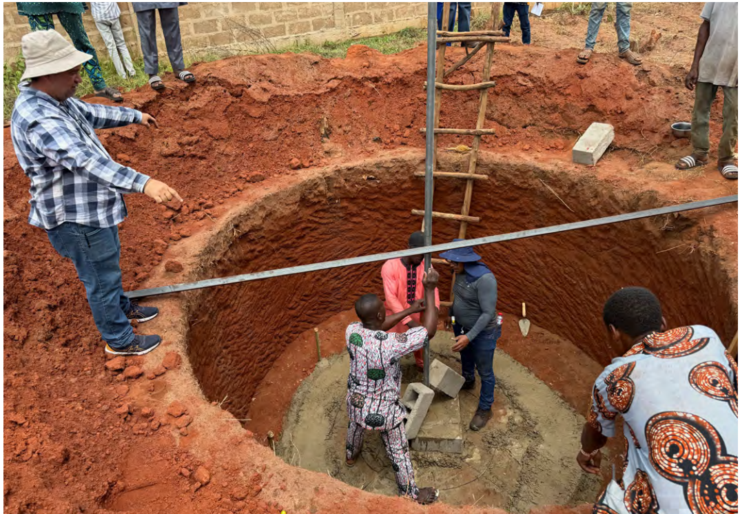
Figure 18a - Fixation du tuyau guide sur la base réalisée en blocs de ciment.
