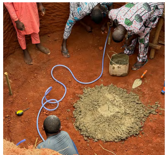
Figure 12 - Application du mortier au fond de la fosse pour la réalisation du sol.
