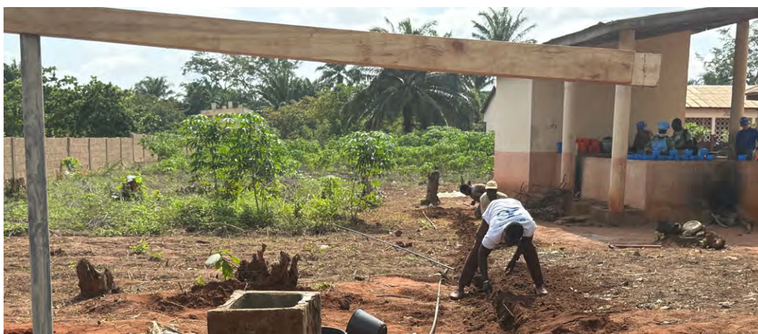
Figure 45 - Mise en place du verrou de sécurité sur l'extrémité droite
