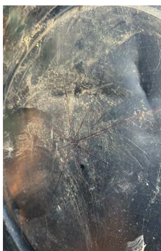
Figure 35 – Emplacement exact du centre de la cuve pour le perçage destiné à l'installation de la bride permettant le passage du tuyau guide
