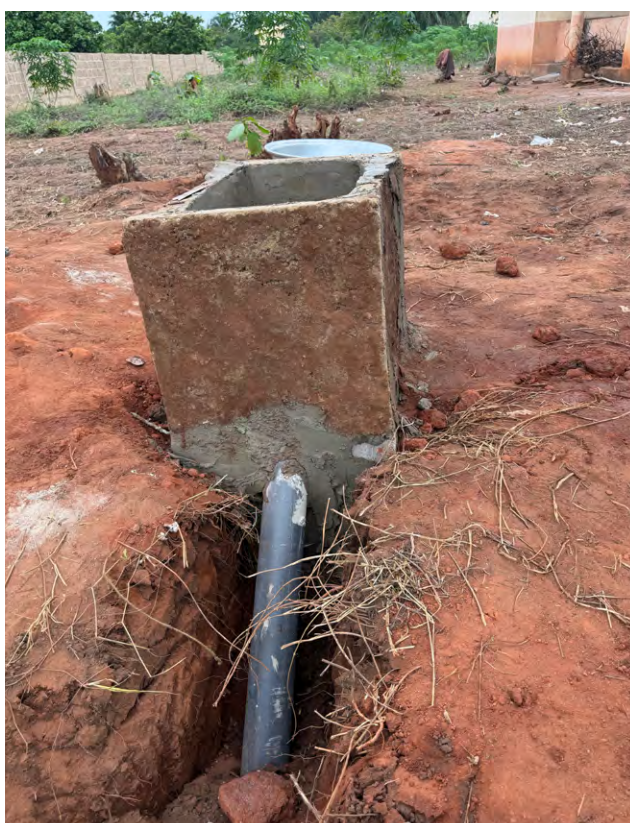
Figure 33 – Cuve de chargement terminée
