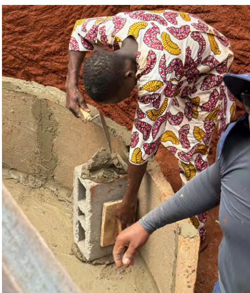
Figure 29a – Positionnement des butées dans le réservoir
