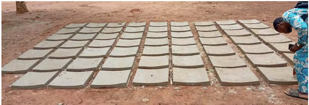
Figure 6 - Plaques de la paroi du réservoir du biodigesteur, déjà démoulées, en cours de séchage.
