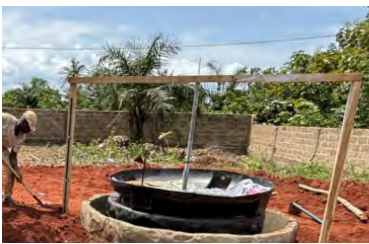
Figure 47 - Vue d'ensemble après la mise en place des traverses
