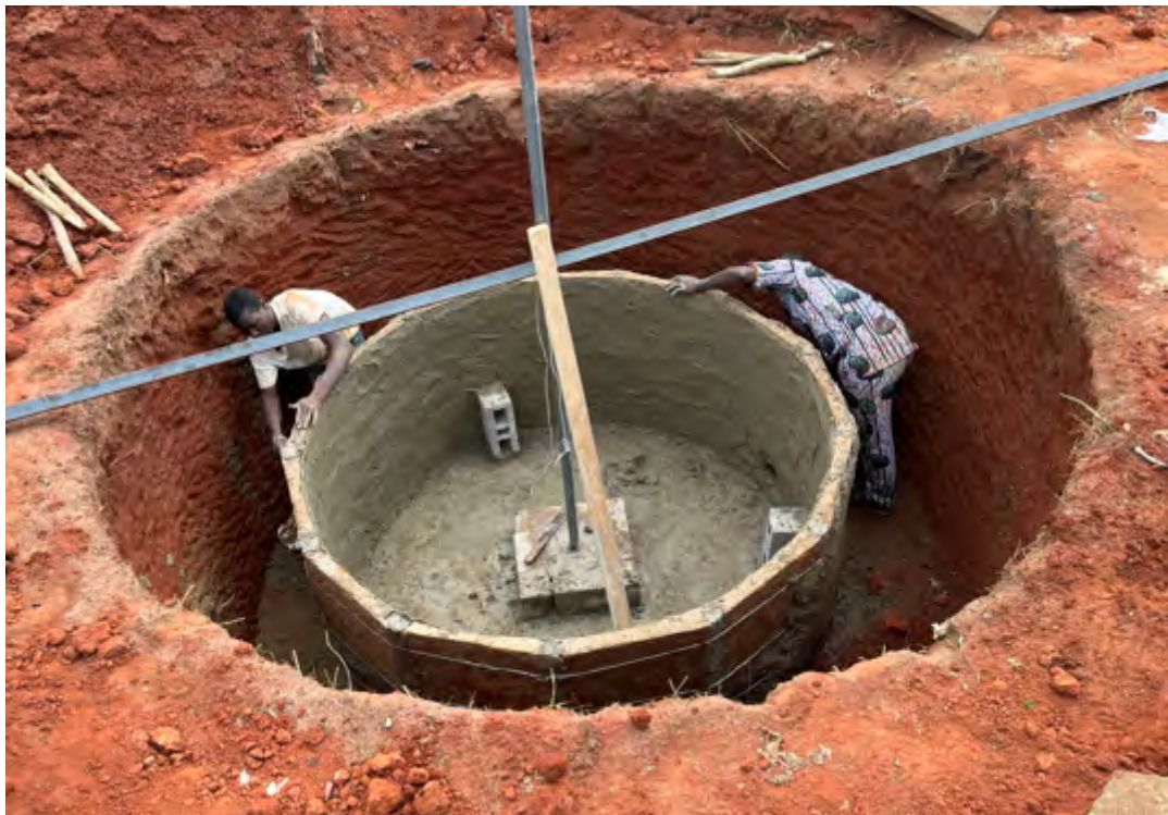
Figure 18b -Tuyau guide installé au centre de la chambre de fermentation, avec une barre en fer et une poutre en bois servant de support afin de le maintenir perpendiculaire au sol
