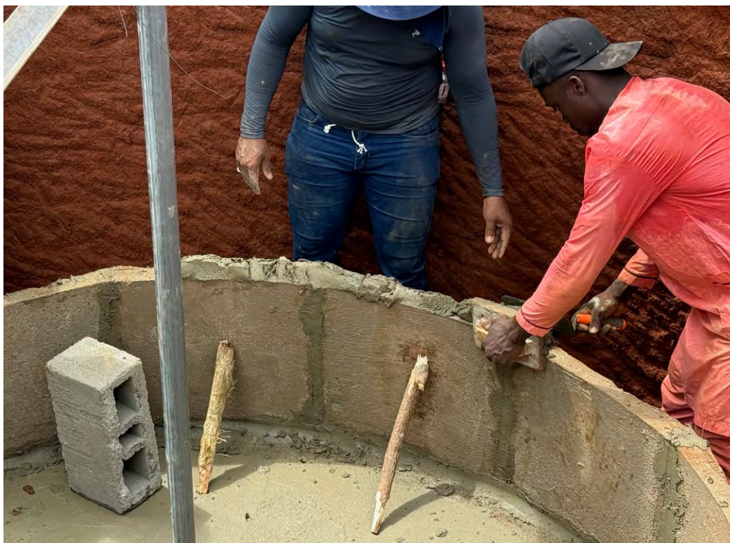
Figure 21 - Mortier pour la fixation de la deuxième rangée de plaques.
