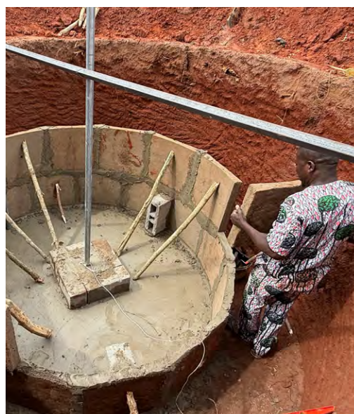
Figure 29b – Positionnement des butées dans le réservoir
