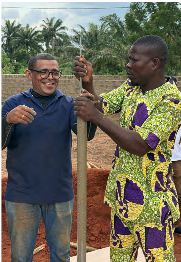
Figure 17 - Boulon fixé dans le ciment
