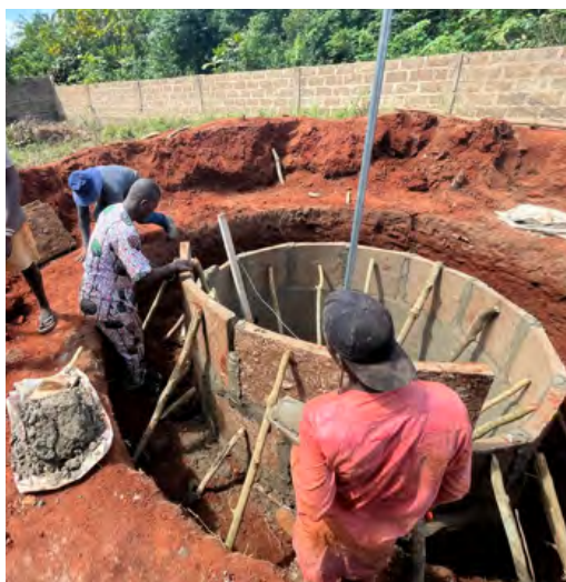
Figure 25 - Étais installés sur la paroi de la cuve de fermentation.
