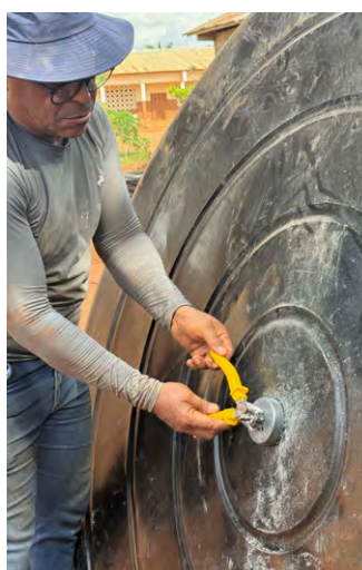
Figure 36 – Perçage au centre de la cuve pour le passage du tuyau guide
