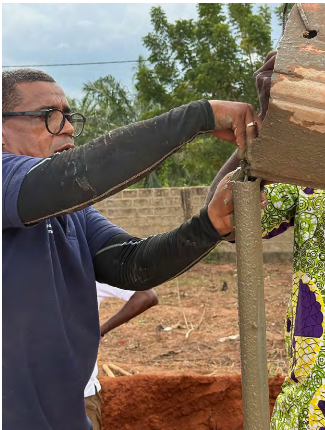
Figure 15 - Coulage du ciment dans le tube en fer.
