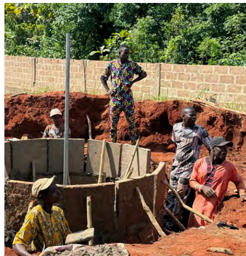
Figure 24 - Détails de l'application de l'enduit entre les plaques de la troisième rangée.
