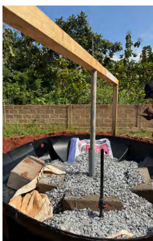
Figure 46 - Fixation des traverses (dispositif de verrouillage de sécurité) de maintien de la cuve
