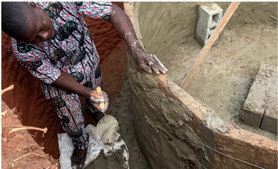
Figure 27 - Enduit de la partie intérieure et extérieure du réservoir
