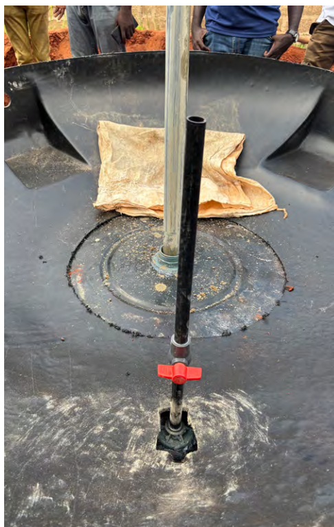
Figure 48 - Tuyauterie de sortie du gaz raccordée à la cuve de fermentation
