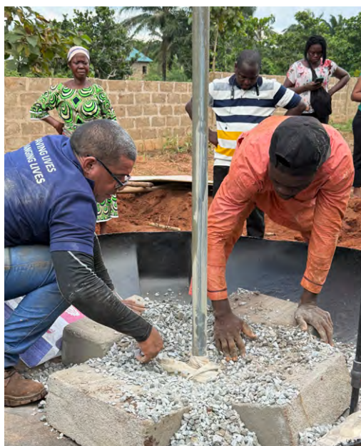
Figure 41 - Mise en place du poids sur la partie supérieure de la cuve de fermentation
