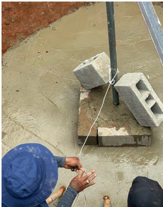
Figure 13 - Fixation du tuyau guide dans le mortier. Les briques inclinées servent d'appui pour maintenir le tuyau guide en position verticale
