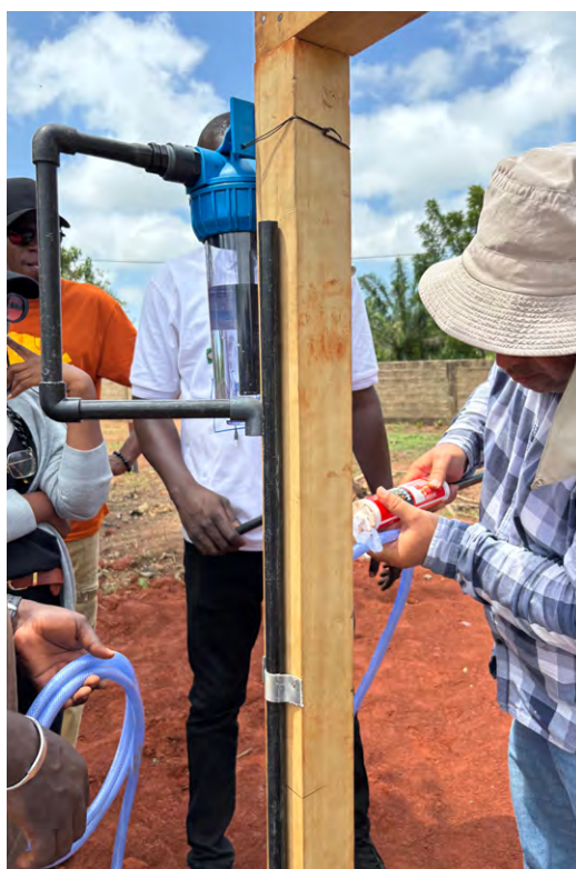
Figure 53 - Installation du filtre coupe-flamme sur le dôme du biodigester
