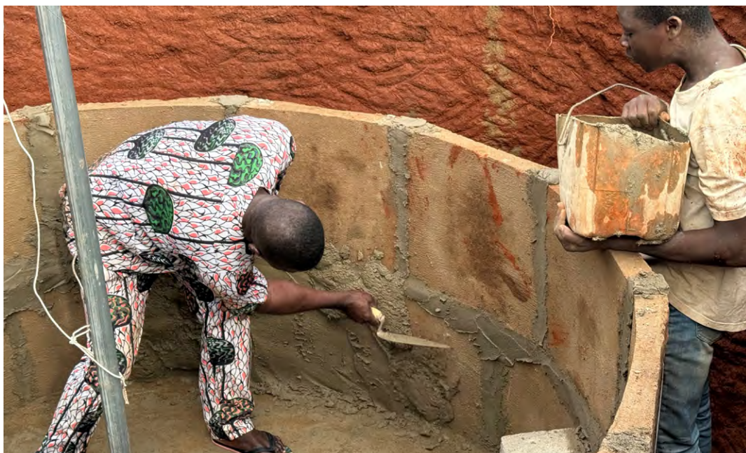
Figure 23 - Fixation de la 2 rangée de plaques, avec réalisation de l'enduit intérieur.
