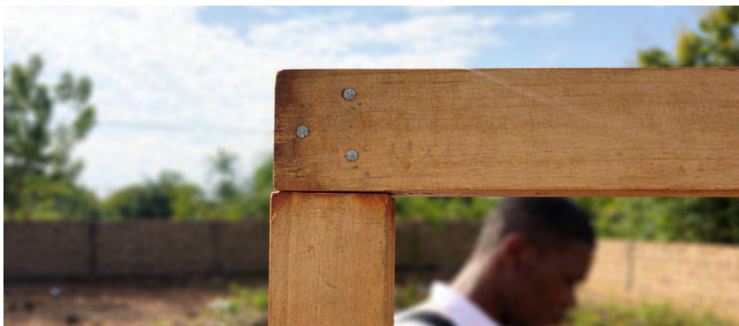
Figure 44 - Détail de l'assemblage en bois
