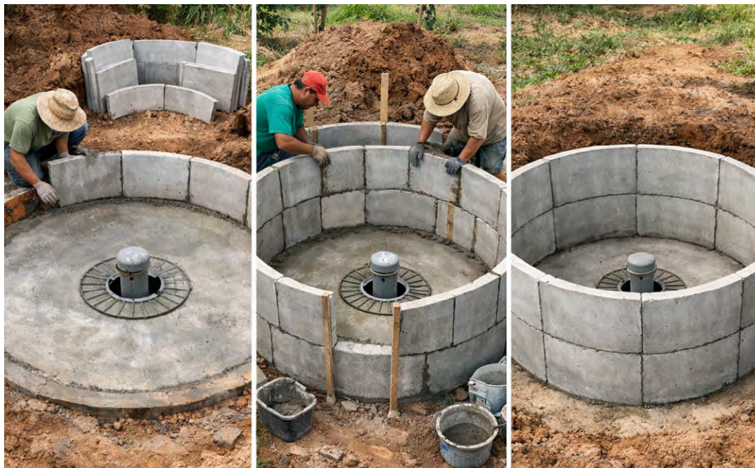
Pisciculture - Construction du bassin en panneaux
