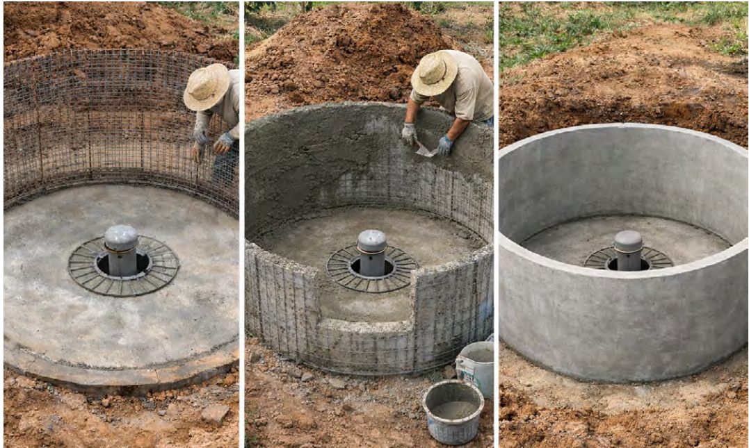
Pisciculture - Construction du bassin en ferrociment
