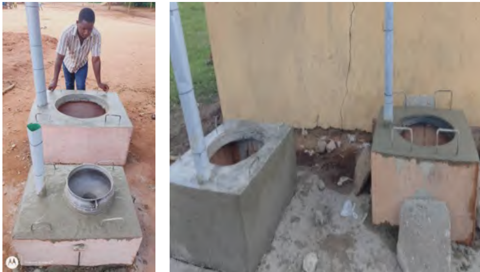
Figure 25 – Foyer de gauche déjà démoulé, en béton et prêt à l'usage ; foyer de droite encore avec le moule en bois en place.
