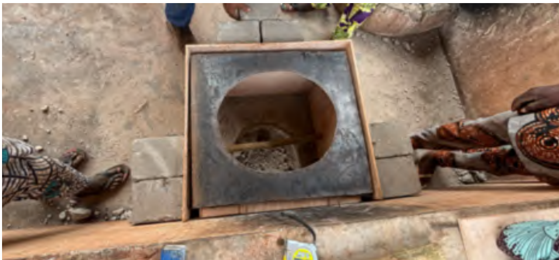
Figure 21 – Blocs de béton placés autour pour soutenir le moule en bois pendant le séchage du mortier.
