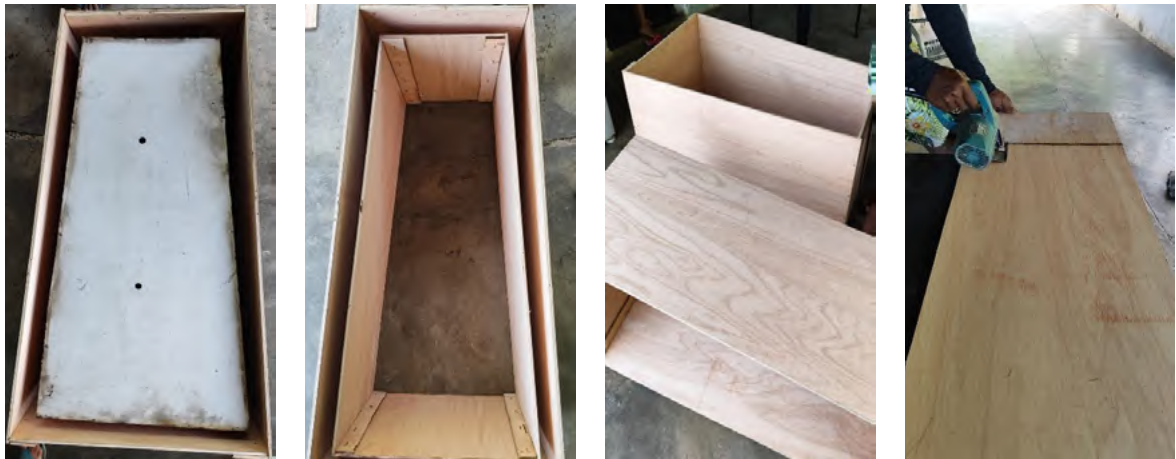
Figure 27 – Moule du foyer à 3 ouvertures en cours de construction.
