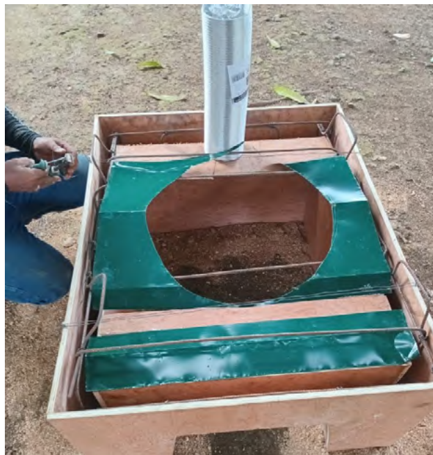
Figure 14 - Moule finalisé, avec l'armature métallique placée dans la structure interne pour assurer le soutien, avant le coulage du ciment destiné aux parois du foyer et le début du moulage de l'ouverture de cuisson (plaque verte).
