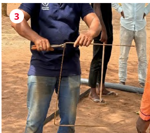
Figure 10 – Retournement des fers selon les dimensions proposées.
