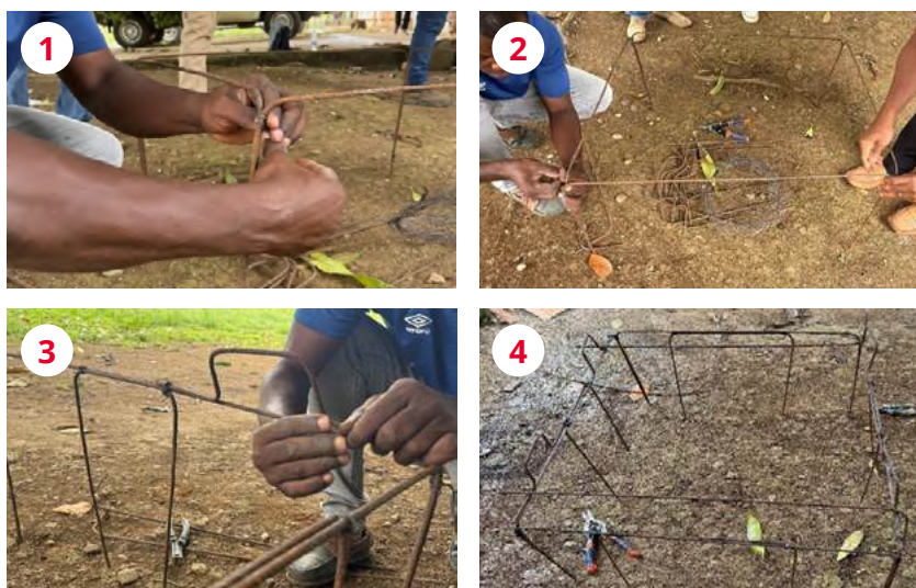
Figure 12 – Étapes pour plier les fers et assembler la structure interne de soutien du foyer.
