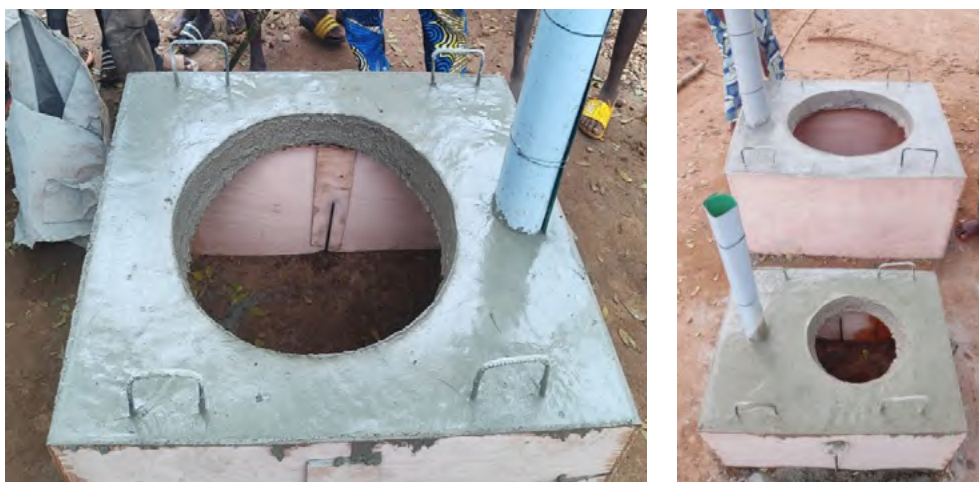
Figure 23 – Foyer en béton avec cheminée, en cours de séchage, encore recouverte du moule en bois.
