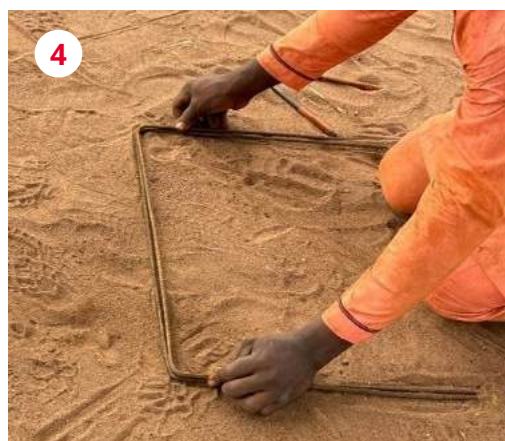
Figure 10 – Retournement des fers selon les dimensions proposées.
