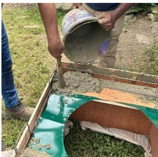
Figure 19 - Remplissage du moule avec du béton et le foyer terminé.
