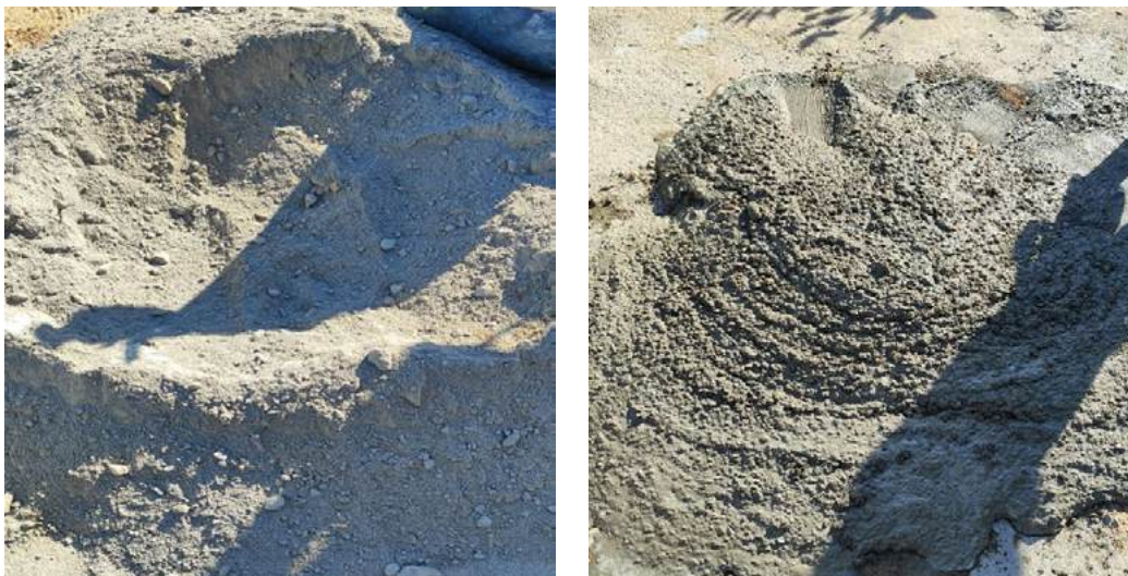
Figure 15 – Préparation du béton.
