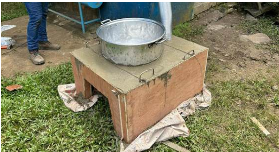
Figure 22 – Moule rempli de béton, armatures des quatre poignées apparentes et marmite en place pour former l'ouverture du foyer.
