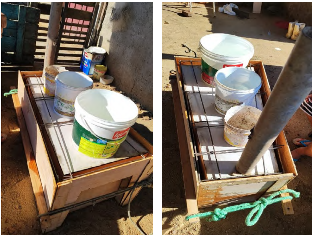
Figure 31 - Mise en place des moules des bouches et du conduit de cheminée.
