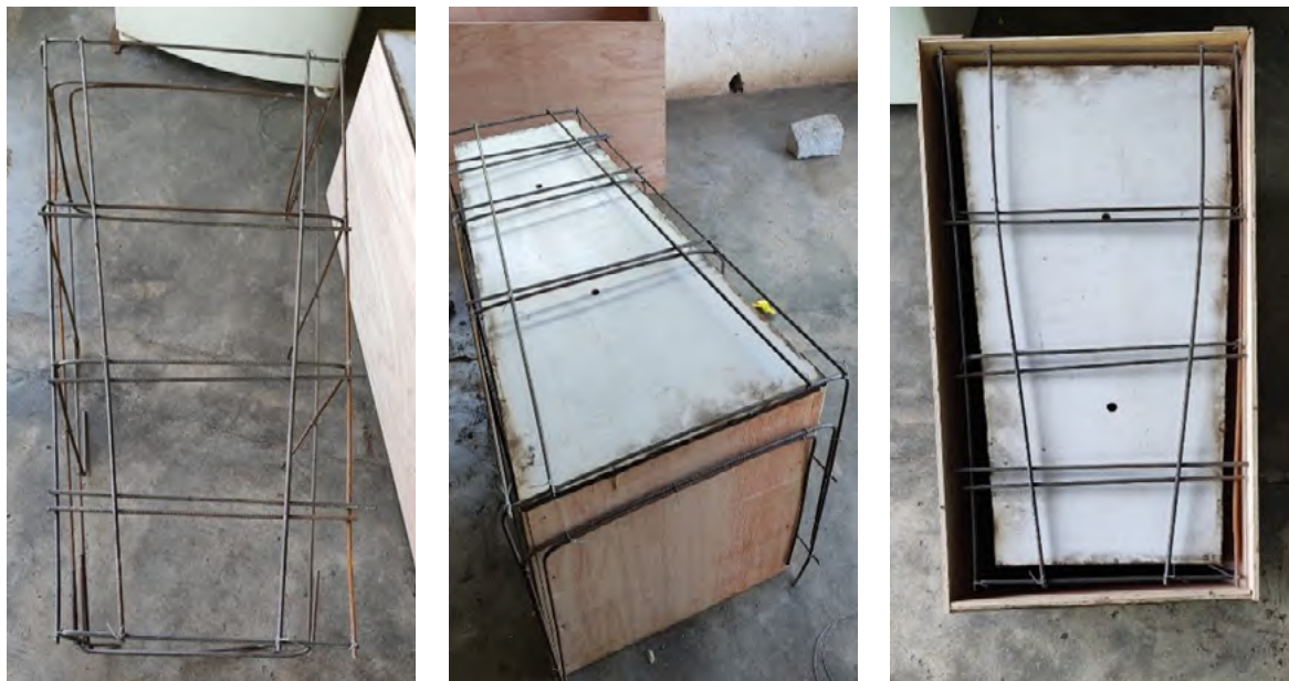
Figure 29 - Montage de l'armature.
