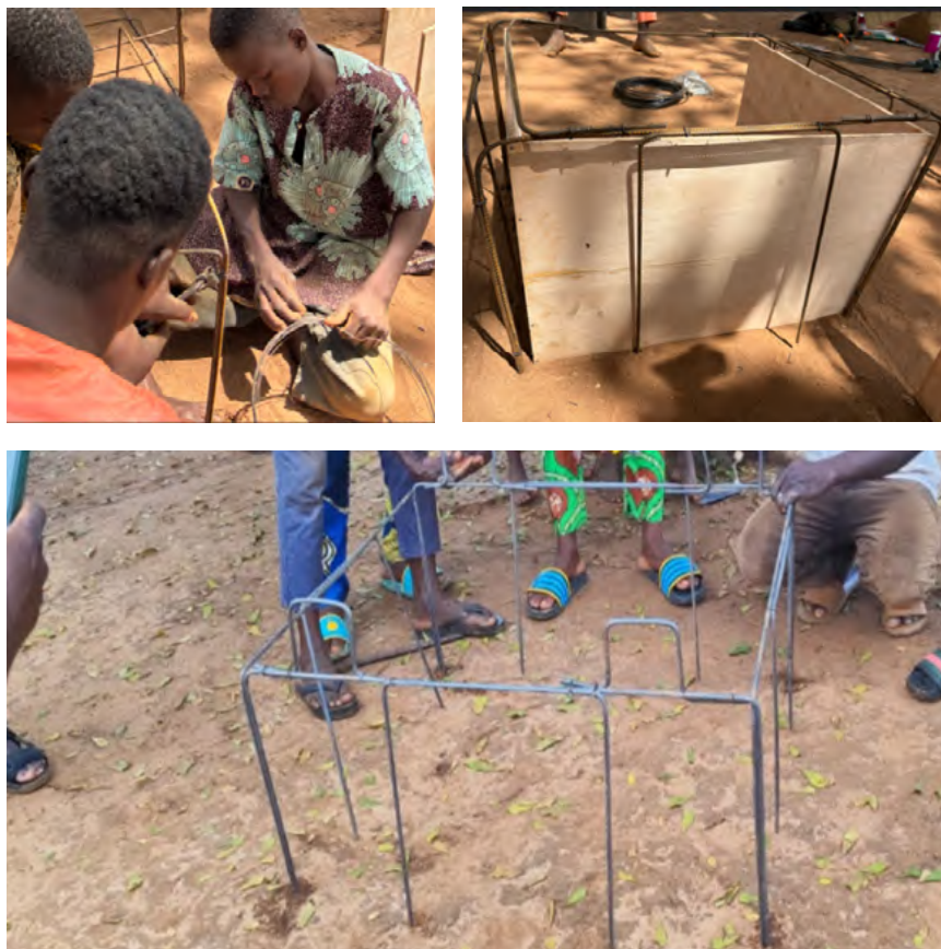
Figure 11 – Structure métallique du foyer terminée.
