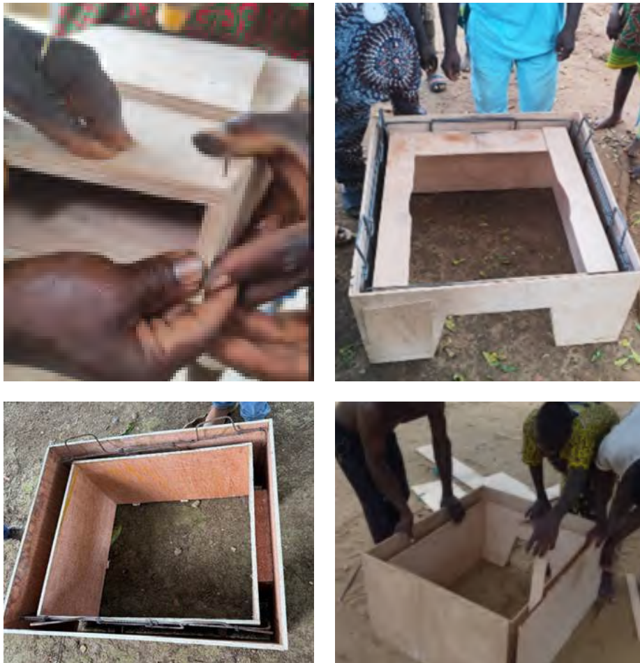
Figure 13 - Moule du foyer avec la petite boîte placée à l'intérieur de la grande boîte, et l'armature métallique de renforcement.
