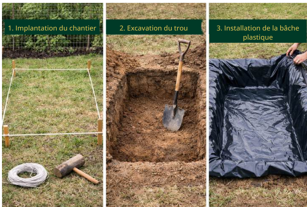
1. Marquage, creusage et mise en place de la bâche sur la planche économique
